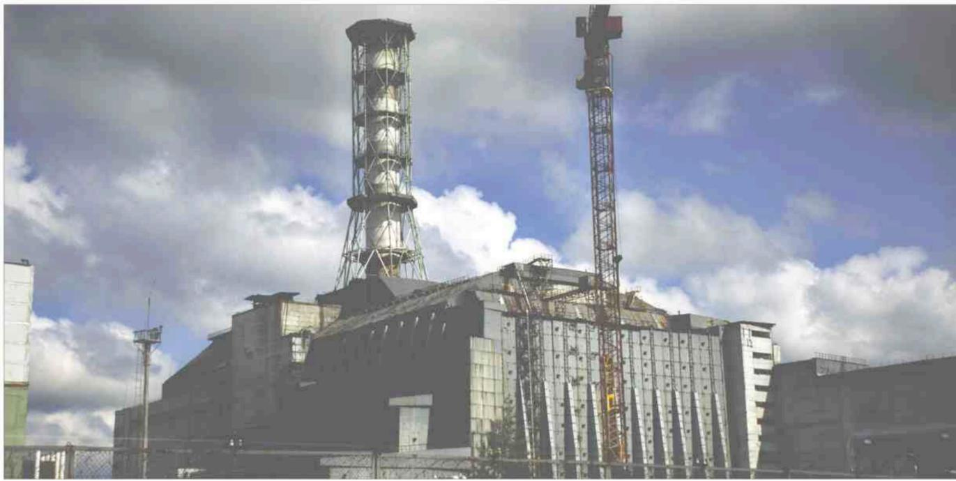
Die Quelle der radioaktiven Strahlung: Der Block IV des Unglücksreaktors von Tschernobyl ist heute von einem „Sarkophag“ umschlossen. Die Betonhülle ist allerdings nicht dicht und droht einzustürzen. Mit Hilfe von Geldern der EU soll eine neue Ummantelung entstehen.
